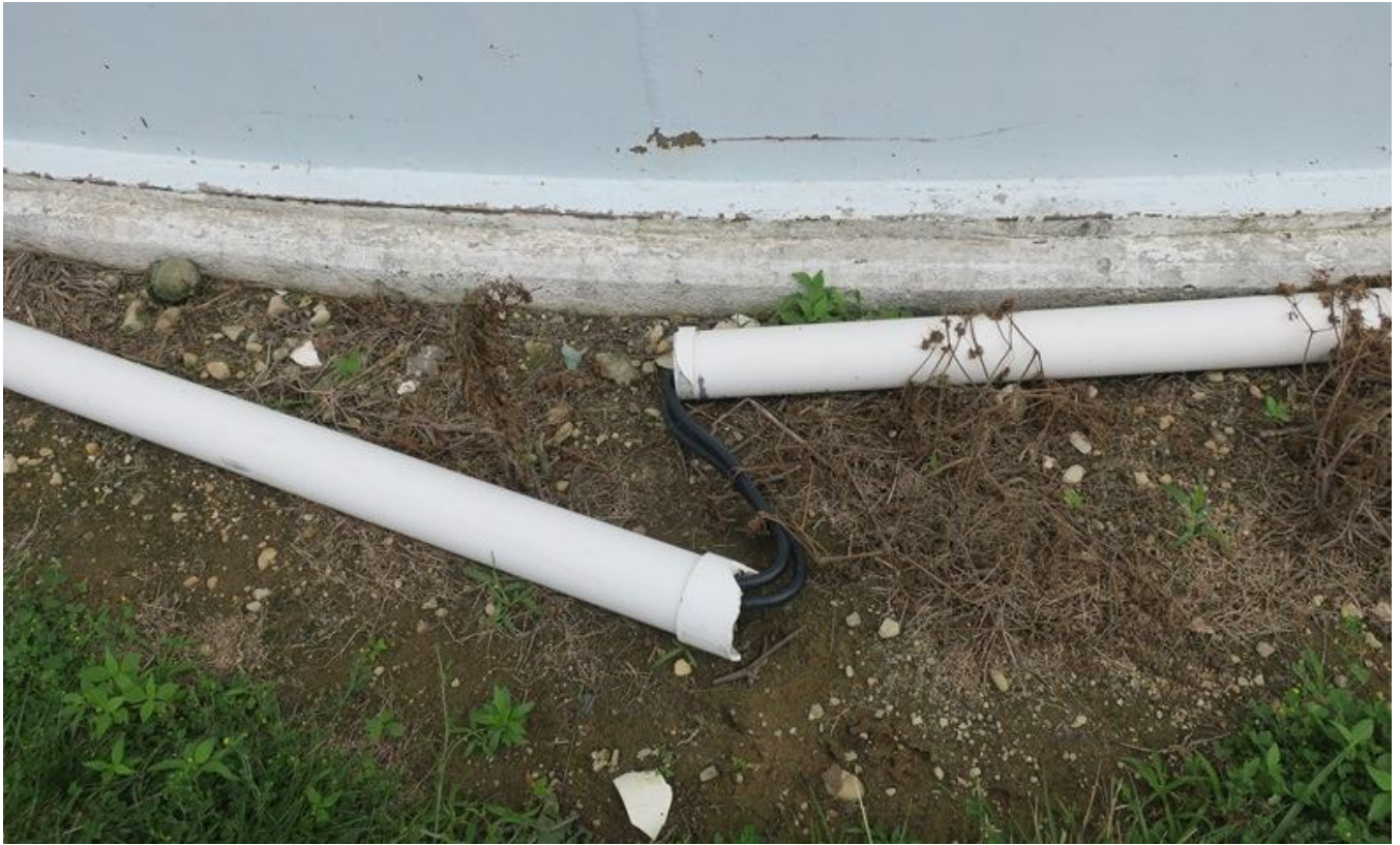
17. Broken electrical conduit exposing cables.
